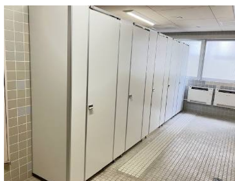
女子トイレ改修後
