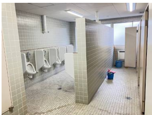
高校本館 2 階男子トイレ改修前
