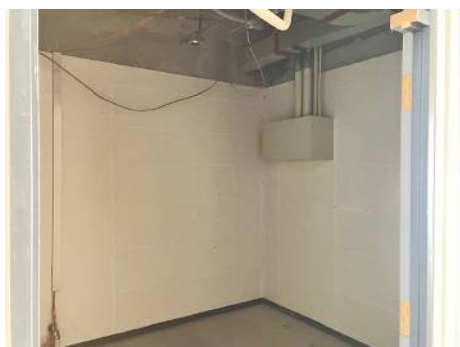
3 号館 6 階倉庫改修前
